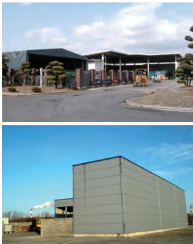
창원공장 폐기물 처리 리사이클링센터 울산공장 폐기물 처리 리사이클링센터
